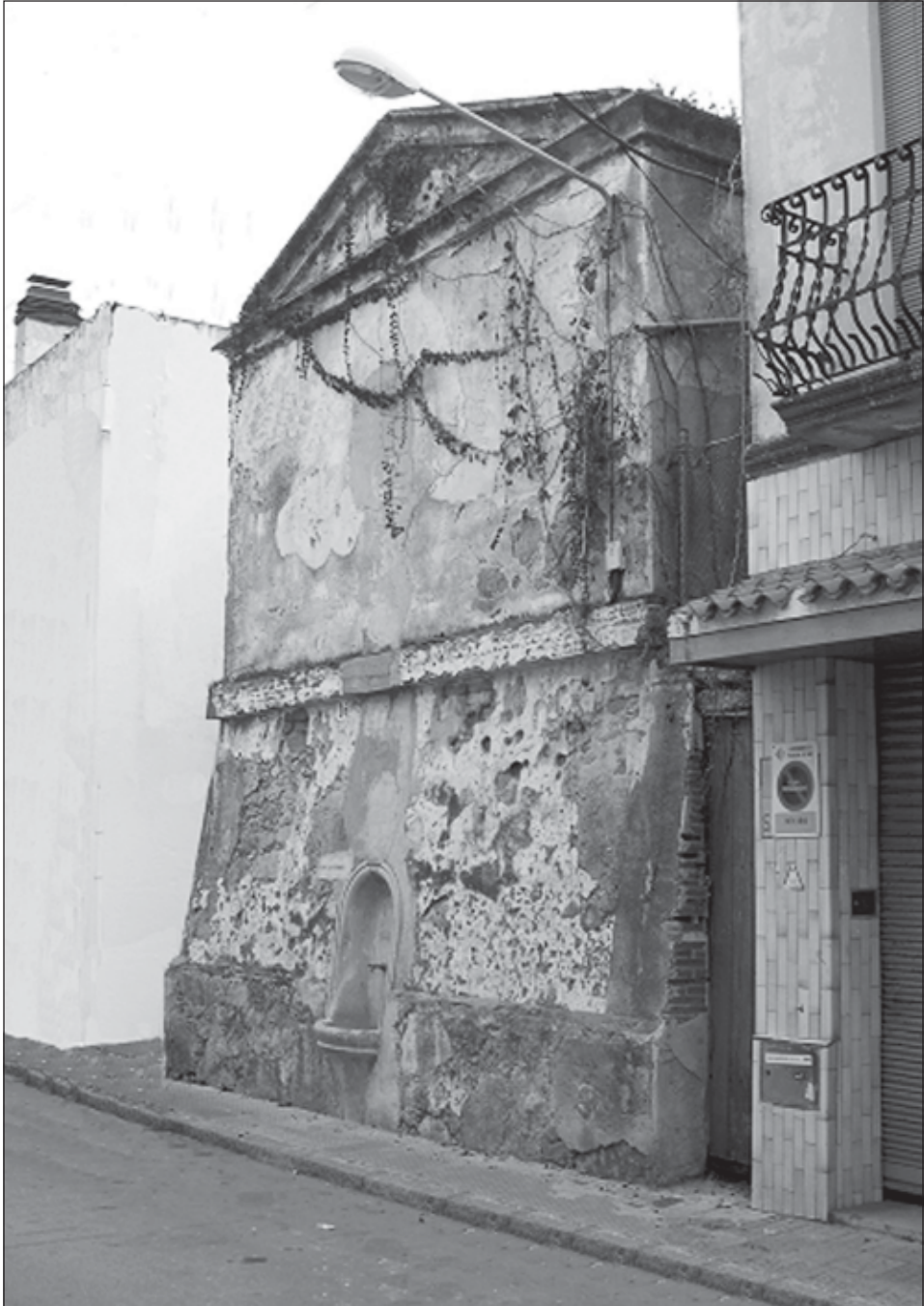
El deplorable estat actual de la «nostra» torre del telègraf òptic, un dels comptats edificis del patrimoni històric que encara ens queden... Per quant temps? (Fotografia de l'autor).
